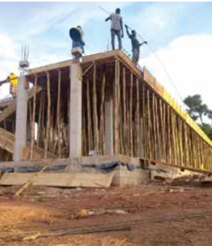
Das neue Lehrerwohnhaus nimmt Gestalt an.
