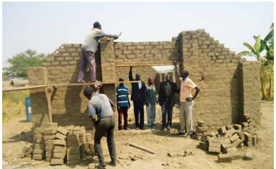
Das Kirchengebäude für die Anyuak Gemeinde entsteht
