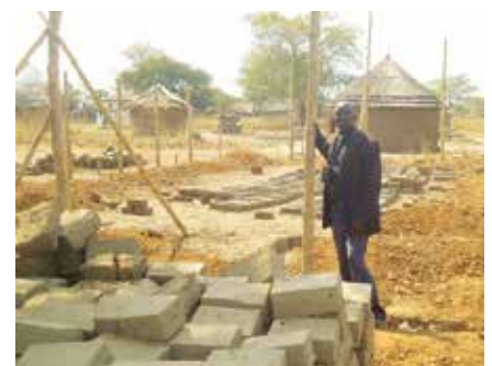
John Tubuwa auf der Baustelle der beiden neuen Gebäude
